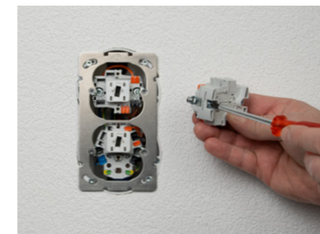
2. Se un adattatore SNAPFIX® è difettoso o manca una staffa di supporto a baionetta, i kit di conversione rappresentano un grande vantaggio.
