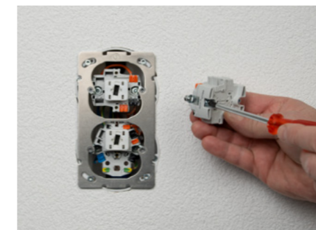
2. Les kits de conversion offrent également un grand avantage lorsqu'un adaptateur SNAPFIX® est défectueux ou qu'un étrier à baïonnette manque.
