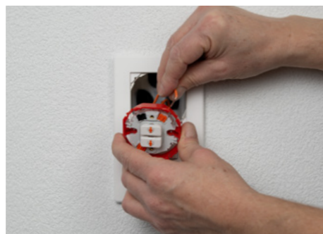
2. Grâce au système de fixation SNAPFIX®, vous démontez le poussoir du store par l'avant à travers le cadre de recouvrement et vous refaites le raccordement.
