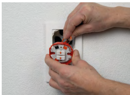
2. Dank dem SNAPFIX® Befestigungssystem demonstrieren Sie den Storenschalter von vorne durch den Abdeckrahmen und schliessen Sie ihn neu an.
