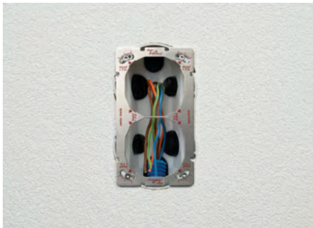
1. Montieren Sie zuerst die Befestigungsplatte.
